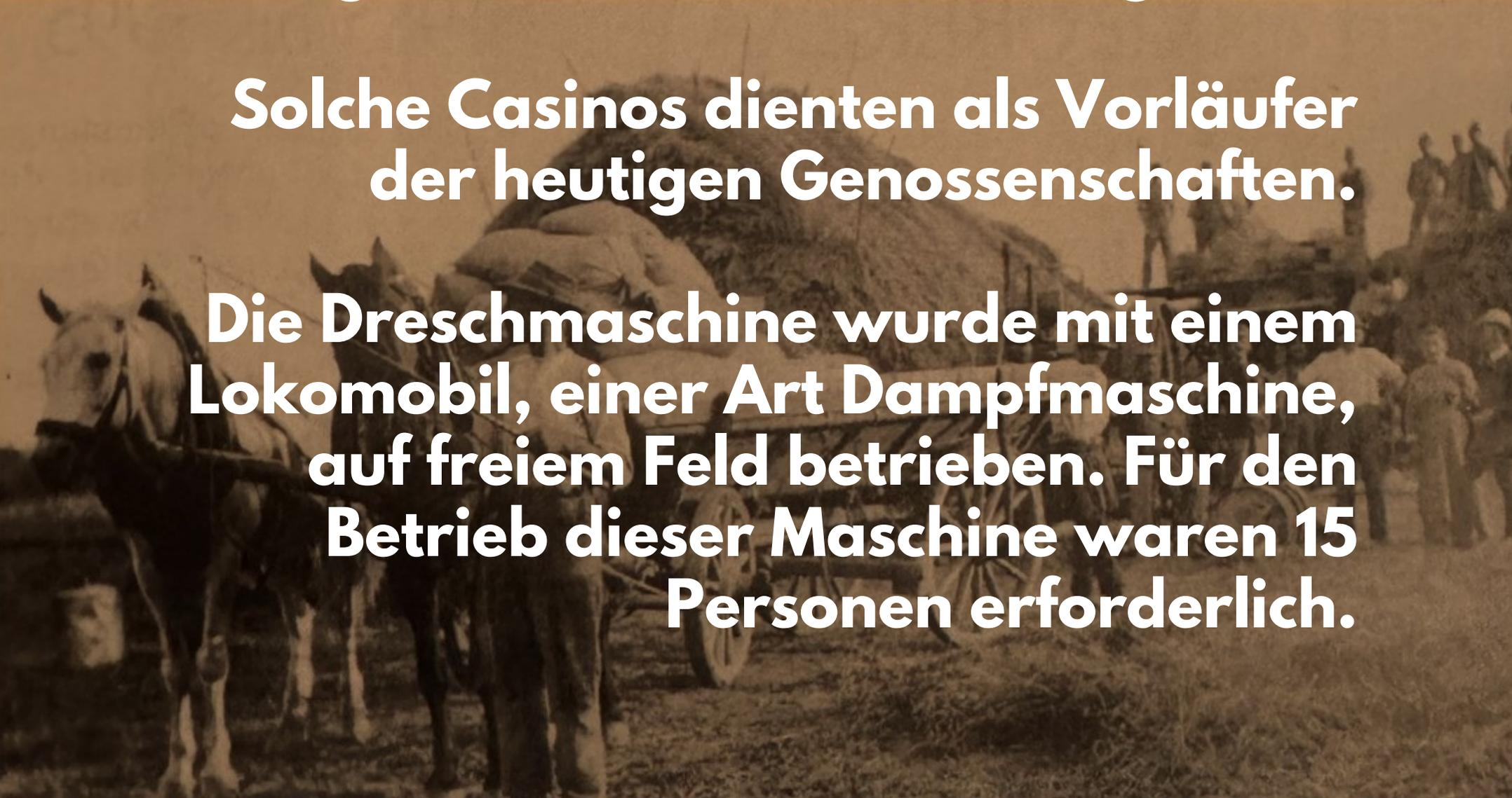
**Die Dreschmaschine wurde mit einem Lokomobil, einer Art Dampfmaschine, auf freiem Feld betrieben. Für den Betrieb dieser Maschine waren 15 Personen erforderlich.**
